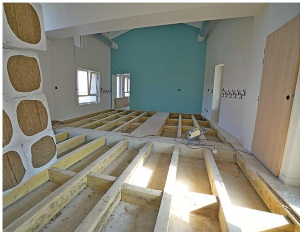
réunion de chantier du 24 Juin, il a été proposé d'installer un déshumidificateur pendant une à deux semaines afin d'accélérer le séchage des bois. Un nouveau plancher sera posé avec une ventilation plus importante. Il restera ensuite à terminer le sol, à finaliser au plafond les éclairages et les caissons pour le bruit, et à adapter la puissance électrique. Puis nous pourrons réceptionner l'équipement, former le personnel, pour enfin mettre en service notre cantine.
