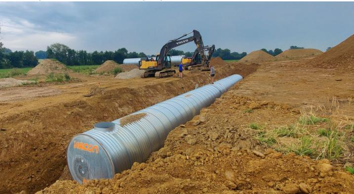
rétenir le flux en cas d'orage, puis dans un bassin de rétention de 66m<sup>3</sup> avec, pour finir, une surverse dans le ruisseau.
